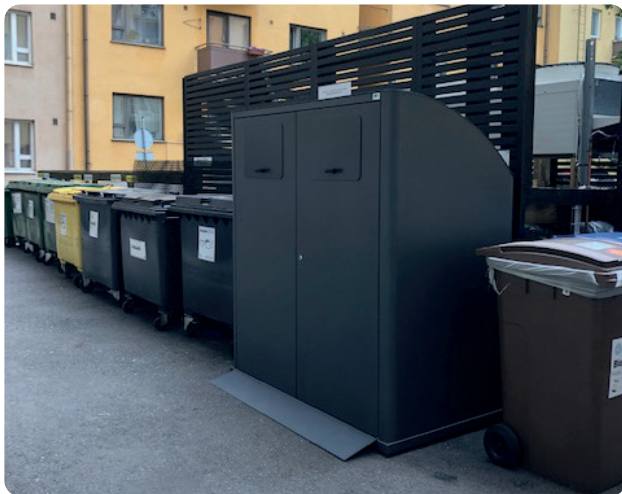
Beholderskap gir et diskret inntrykk og beskytter mot skadedyr.
