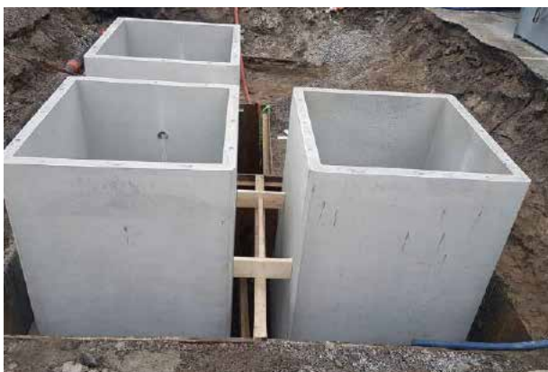
Avstandsstykker for å sikre enkel montering (NB - bilde er på betong uten montert sikkerhetsgulv)
