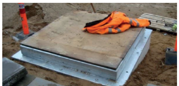
Dekk til åpning med en kraftig finérplate.
